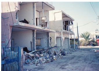
בית באזור הסמוך לבני ברק שנהרס כתוצאה מפגיעת טיל
